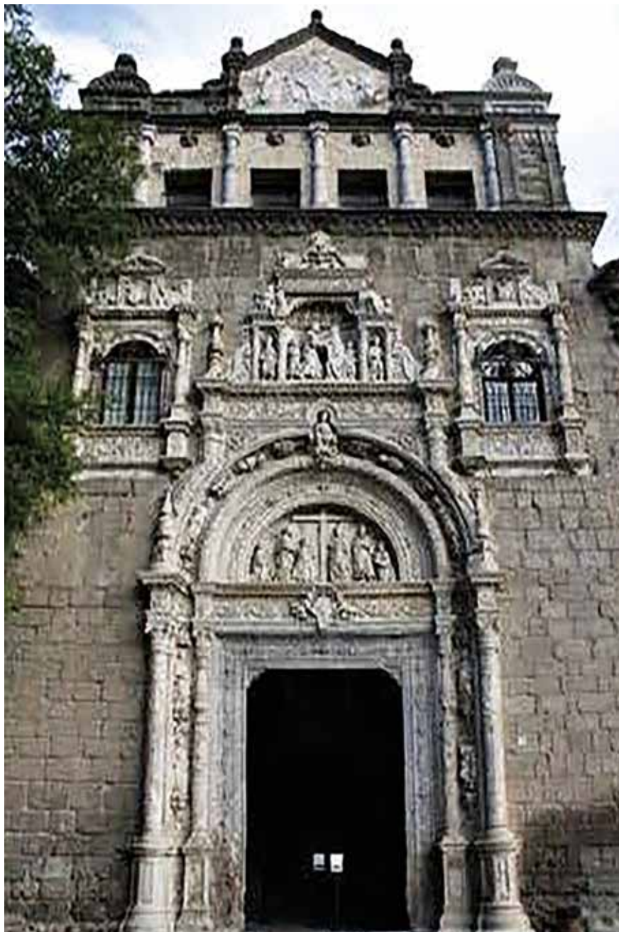
Puerta principal actual restaurada
